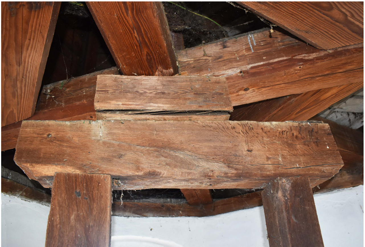
Obr. 148: Konstrukce krovu věže (Veselá 2020).
