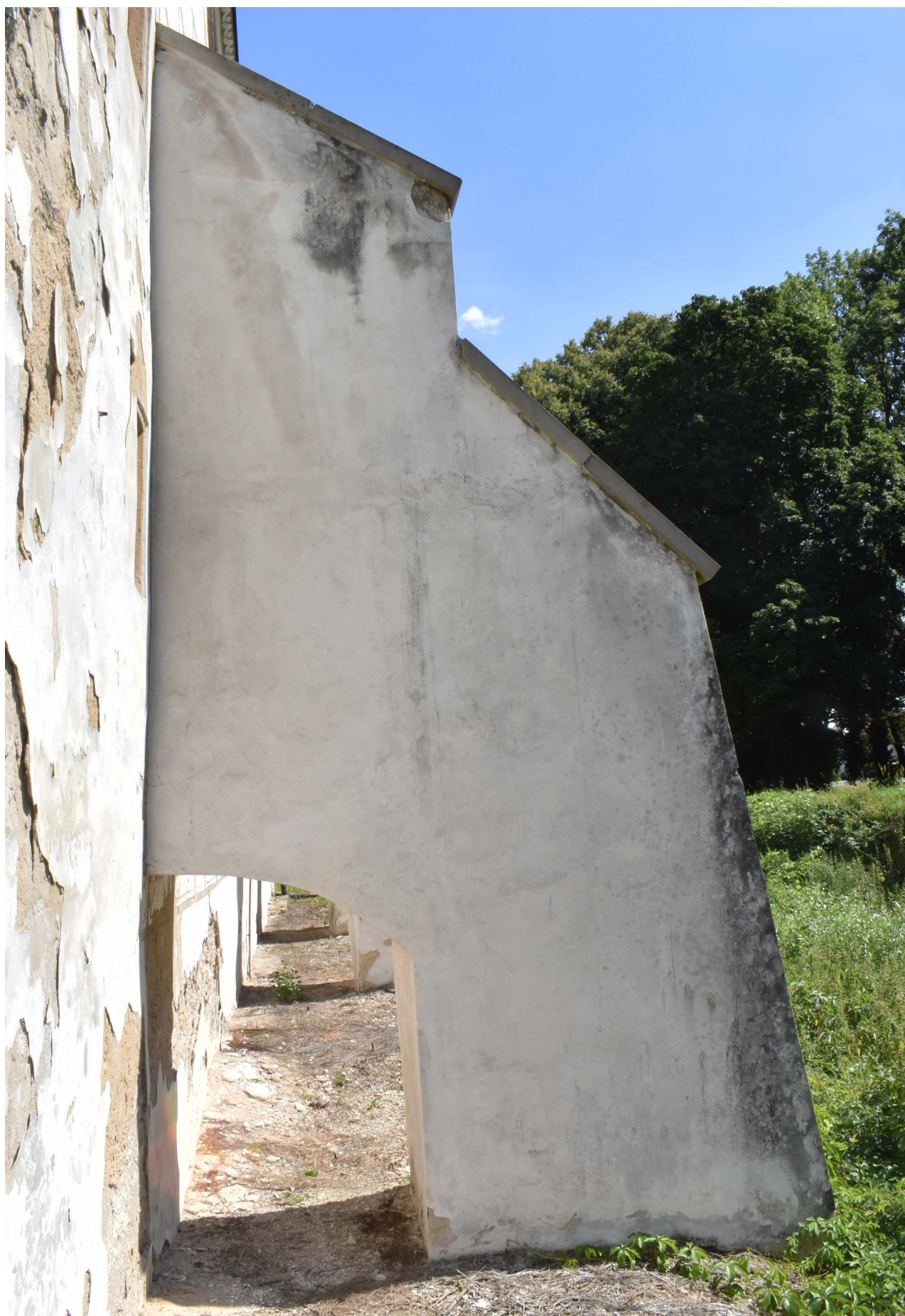
Obr. 19: Jeden z opěrných pilířů při jižním průčelí jižního křídla (Veselá 2020).
