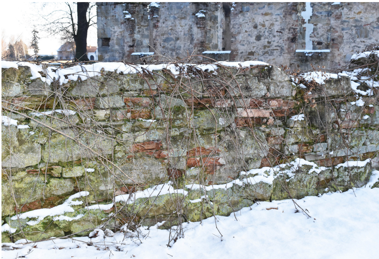
Obr. 166: Odkryté zdivo východní poprsní zdi mostu (Veselá 2020).
